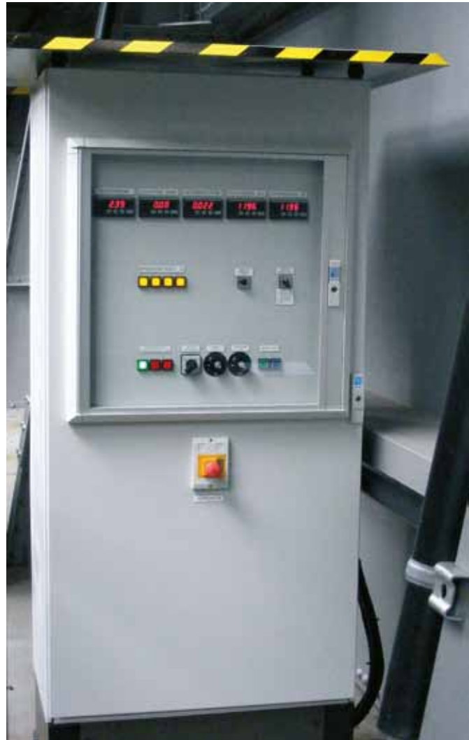
Standard Schaltschrank 1800 x 800 x 500 mm, Sockel 100 mm für DC Ausgangsleistungen bis max. 5 kW
