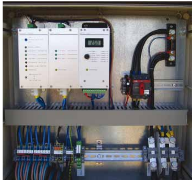
Typisches Gehäuse mit einer Master-unit, einer Slave-unit und einer CCU- Meter Unit
